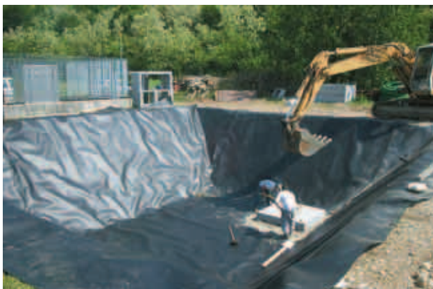
L'impianto di fitodepurazione di Purgessimo: impermeabilizzazione della vasca
