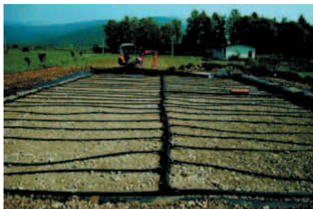
Completamento dell'opera con posizionamento del sistema di subirrigazione
